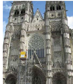
Travaux d'entretien de la façade de la cathédrale de Tours.
